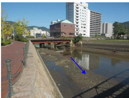
④堺川下流 (JR橋梁下流)
