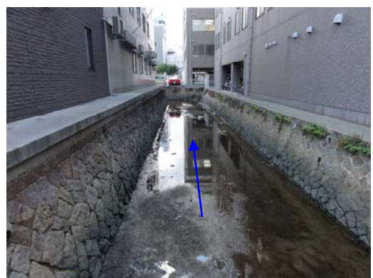
③内神川下流(開水路下流端)
