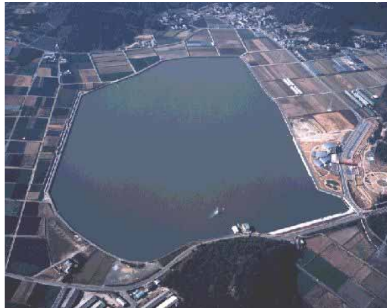
出典: 愛知県HP, 芦ヶ池調整池
