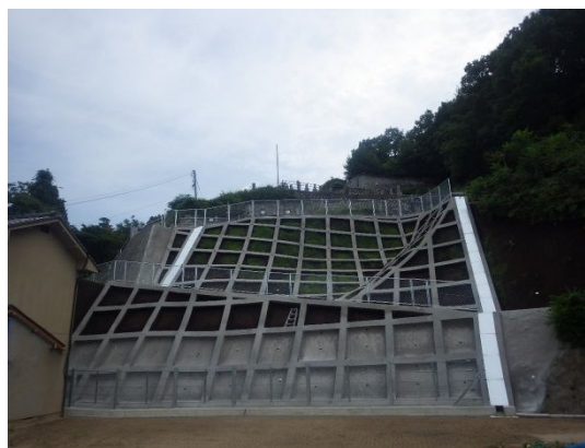
広谷地区 災害関連緊急急傾斜地崩壊対策事業
