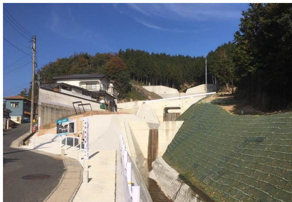
県砂防事業 根谷川支川101
