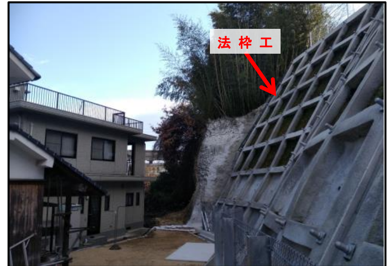
【工事完了 (H30.2月)】
