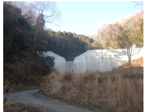
賀茂川支川砂防施設（竹原町東野町）
