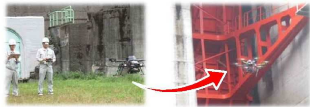
ドローンを活用した施設点検
