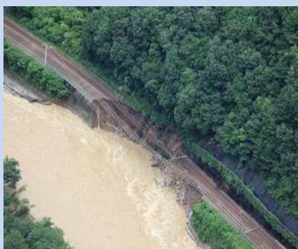
J R 山陽本線 (河内～本郷駅間)
