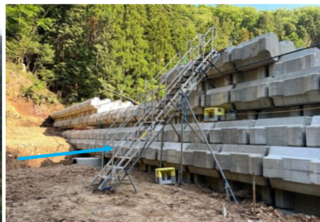
ブロック堰堤設置状況
