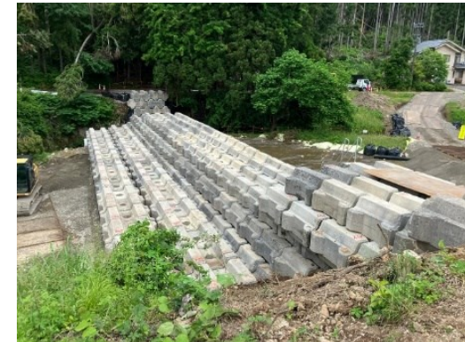
ブロック堰堤設置状況
