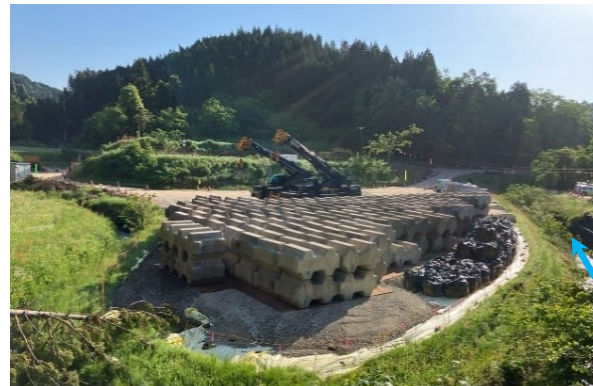
ブロック運搬完了
