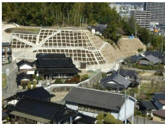
急傾斜地崩壊対策事業の施工例
