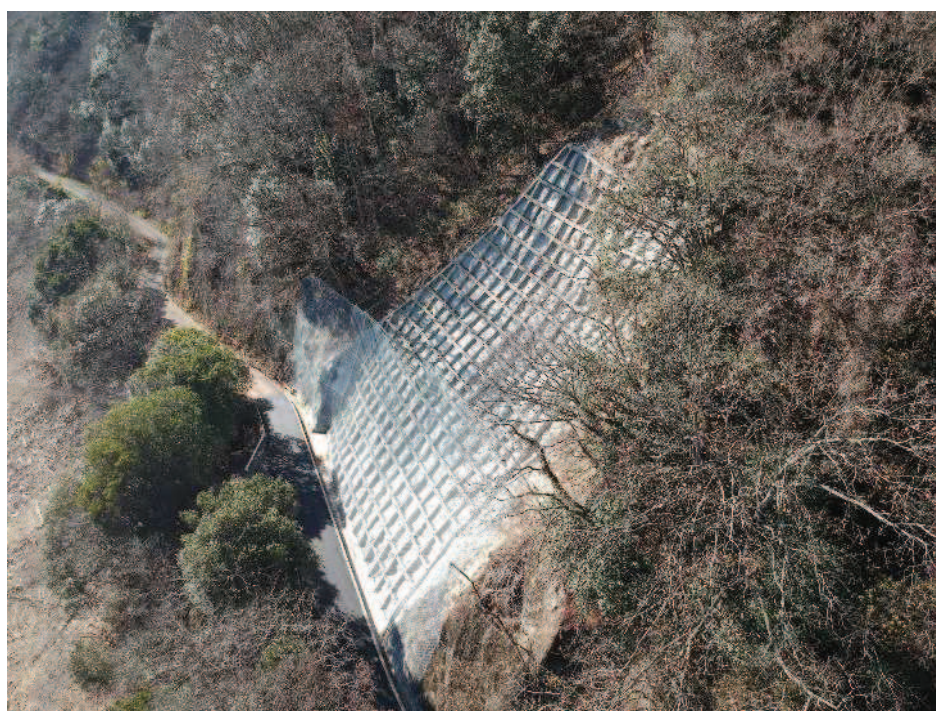
令和5年発生災害 一般県道 奈良備中線 道路災害復旧工事（神石高原町小野）
