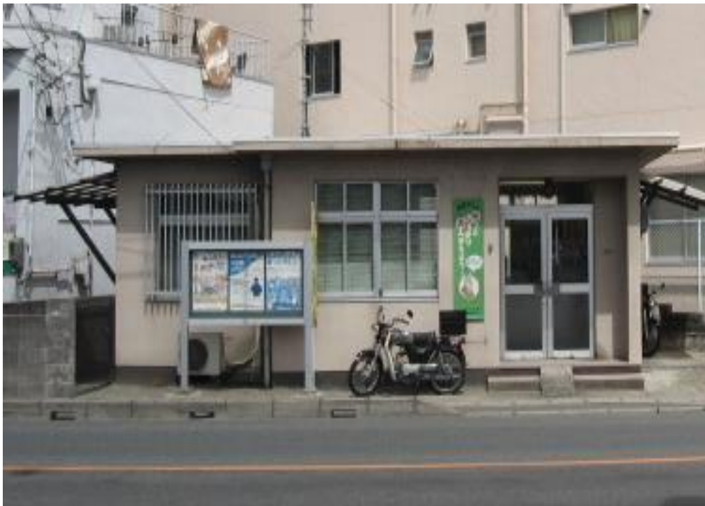
広島南警察署青崎交番（昭和 32 年建築）
