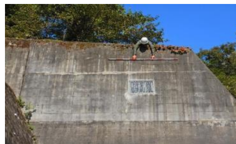
砂防堰堤点検状況
