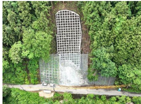
復旧後（令和5年6月）
