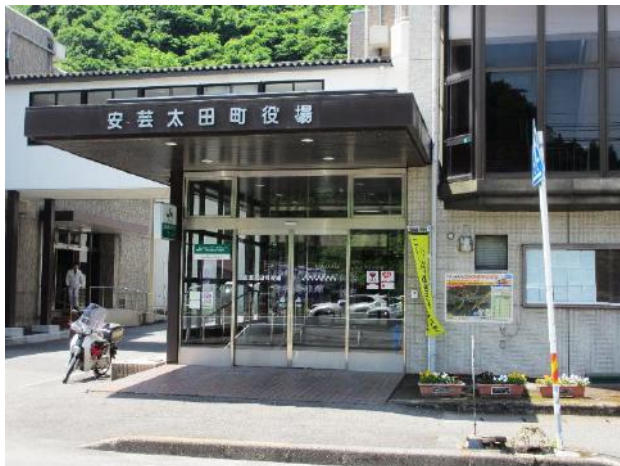
標識設置状況（安芸太田町役場）
