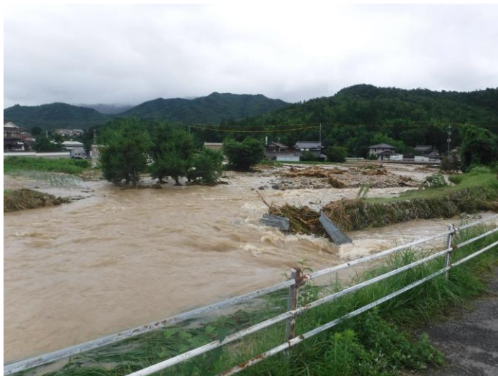
出典：熊野町「平成30年7月豪雨の検証結果報告書」/三谷川（初神地区）の決壊の様子
