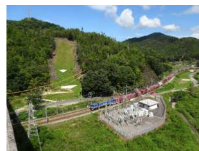
山腹工(東広島市)
