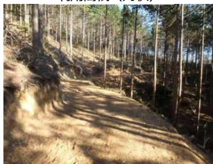
森林作業道の開設
