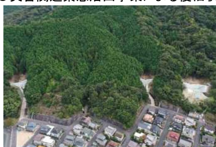
溪間工(広島市)
