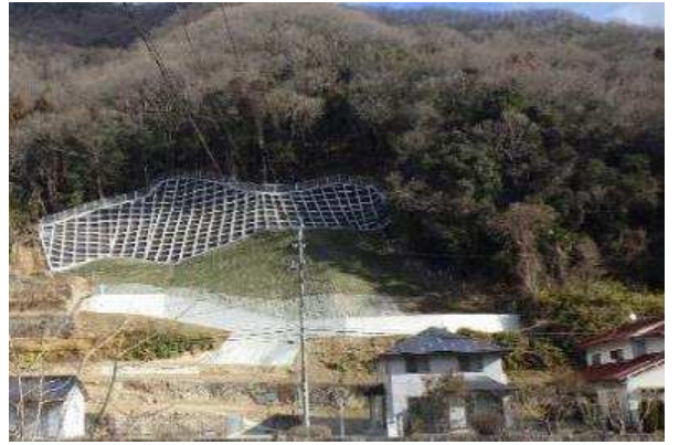
山腹工: 令和3年2月8日完成(竹原市)
