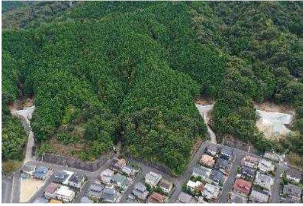
溪間工: 令和2年10月29日完成(広島市)
