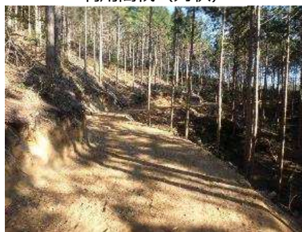
森林作業道の開設
