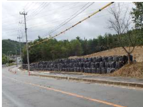
応急工事・大型土のう設置(東広島市)
