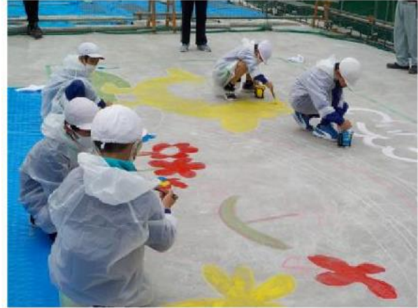
現場見学会・橋梁床版へのペイント体験 (令和2年10月)
