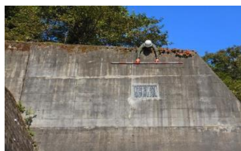
砂防堰堤点検状況
