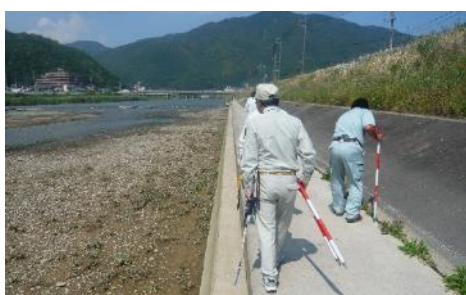
河川点検状況
