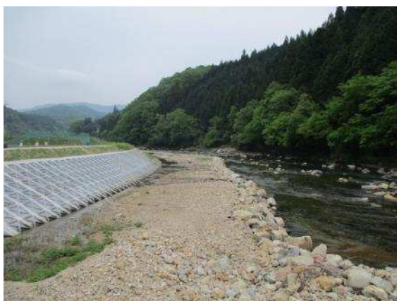
広域基幹河川改修事業(江の川・川戸工区)
