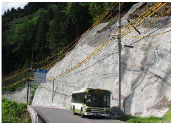
(国) 191号 落石防止網・モルタル吹付 安芸太田町川手(旧戸河内町)
