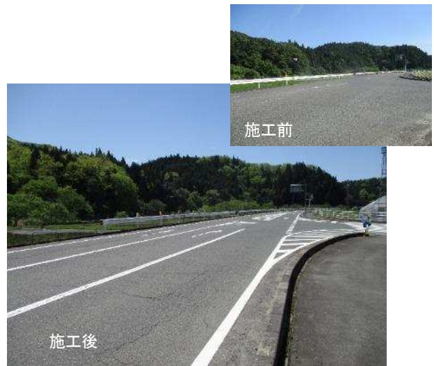
(国) 433 号 路面表示 北広島町（旧千代田町）
