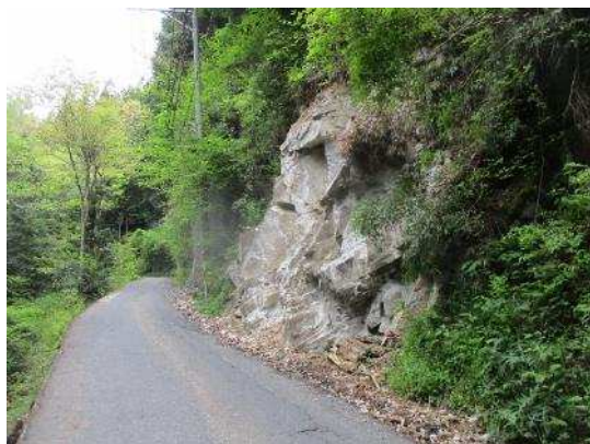
(一) 恐羅漢公園線 法面補修工事 安芸太田町吉和郷(旧戸河内町)
