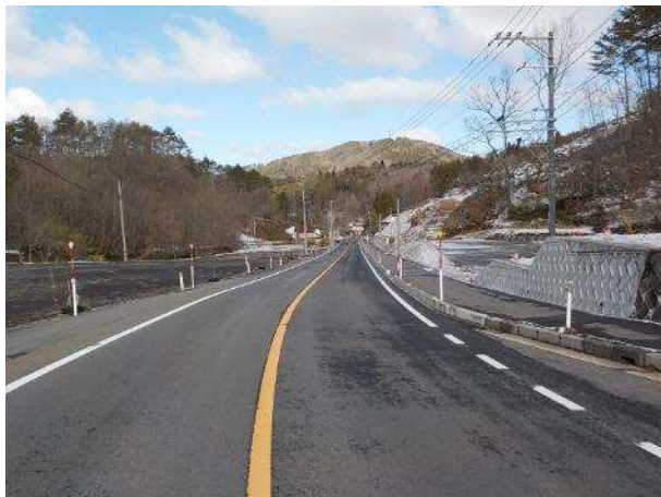
(国) 186 号 歩道の整備 北広島町（旧芸北町）
