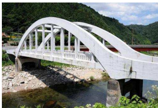
出合橋（安芸太田町遊谷）
