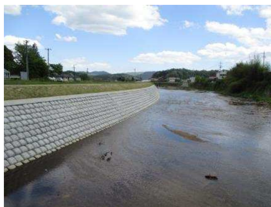
広域基幹河川改修事業(志路原川・春木工区)
