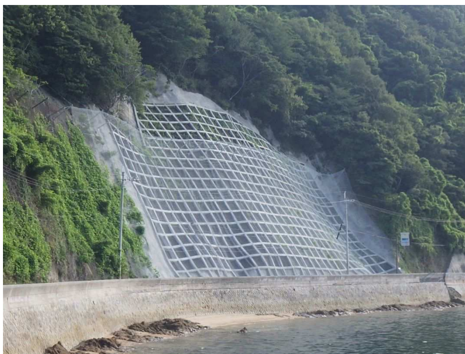
令和3年発生災害 一般県道 大崎下島循環線 道路災害復旧工事（呉市豊浜町）
