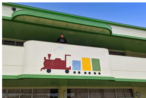
廃園となった幼稚園をサテライトオフィスに改修 (江田島市)
