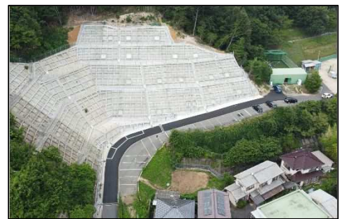
急傾斜地崩壊対策事業 (広島市 山根町5地区)
