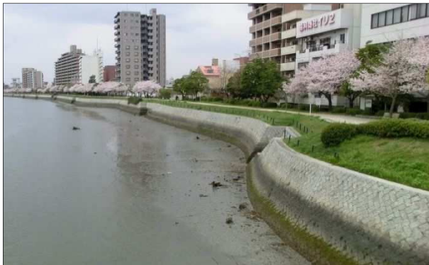
京橋川防潮堤
