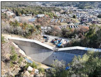
砂防激甚災害対策特別緊急事業 (熊野町 熊野川支川2)
