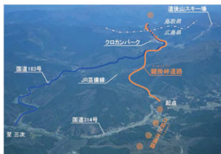
国道183号鍵掛峠道路
