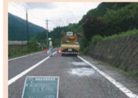
日々の道路パトロール (発見した穴の舗装補修状況)
