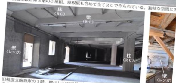
旧被服支廠倉庫の1階。壁はレンガで柱・梁・床はRC。従来の技術であるレンガ造をベースに、RCを組み合わせているように思える。
