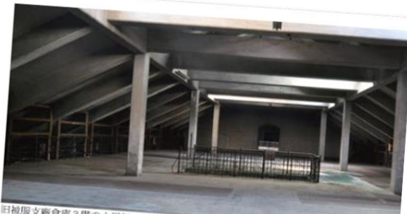
旧被服支廠倉庫3階の小屋組。屋根板も含めて全てRCで作られている。独特な空間に天
