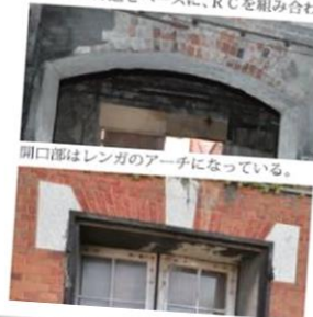
旧被服支廠倉庫の1階。壁はレンガで柱・梁・床はRC。従来の技術であるレンガ造をベースに、RCを組み合わせているように思える。
