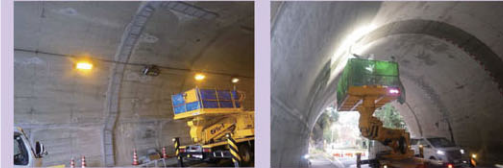
【トンネル補修】 国道184号 木門田トンネル (尾道市木ノ庄町) 【R2 完了】
