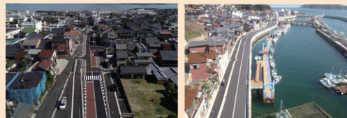
(都) 忠海中央線 (一) 豊島線 小野浦工区 (竹原市忠海中町) (呉市豊浜町) 【H30 完成】 【R1 完成】
