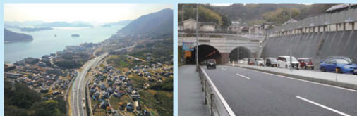
国道2号 木原道路 (尾道市福地町～三原市糸崎) 【R2 完成】
