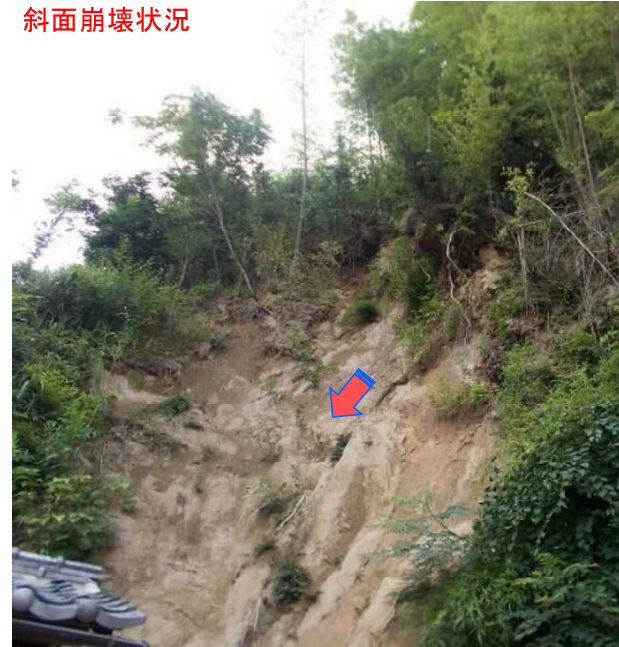
斜面崩壊状況
