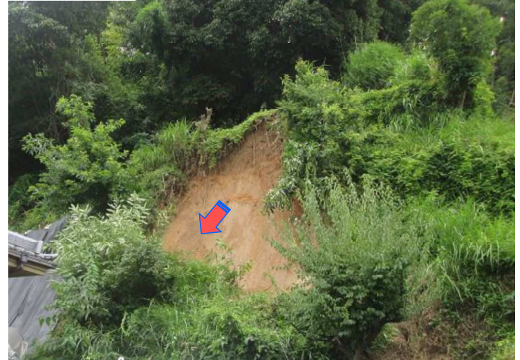
斜面崩壊状況
