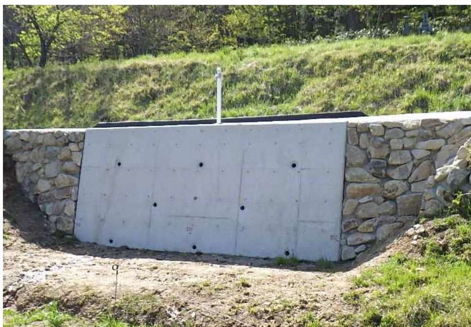
令和 2 年発生災害 主要地方道 旭戸河内線 道路災害復旧工事（北広島町 才乙）
