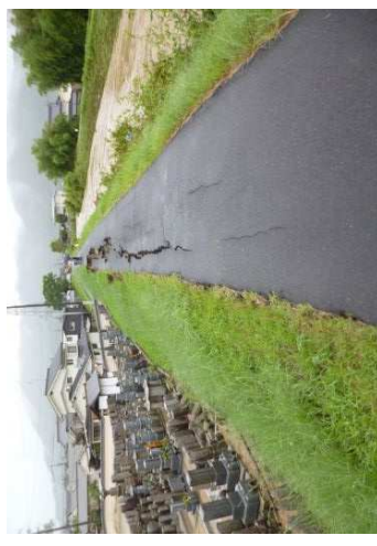
被災状況(駅家町倉光)
