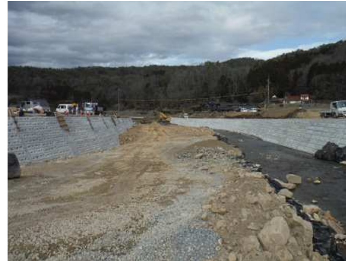
【河川改修】板木川（下志和地町） 令和2年度工事 護岸工
