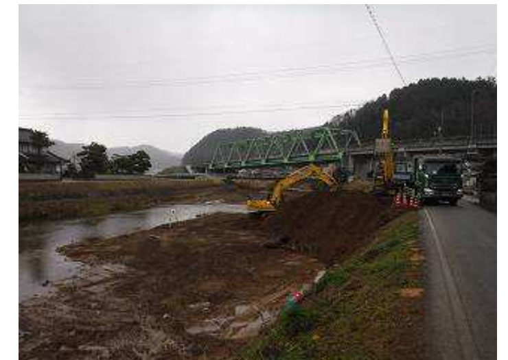
河川 浚渫状況
