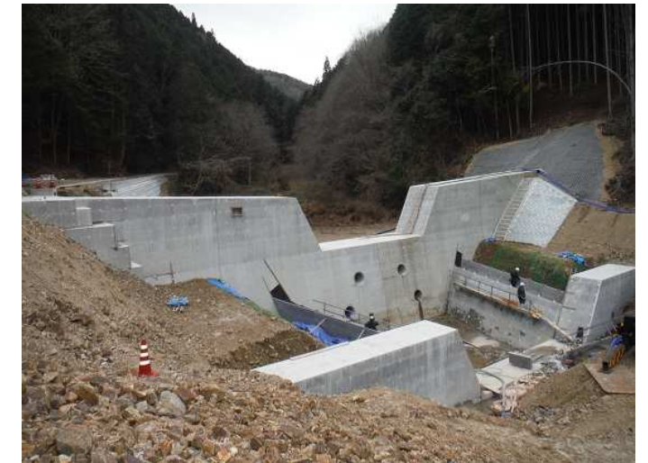
【砂防】桜谷川（吉舎町） 令和2年度工事 堰堤工
