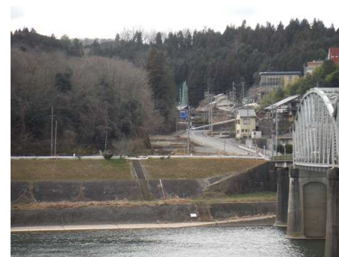
【道路改良】三次江津線(三次町～粟屋町工区) 令和2年度 用地買収
