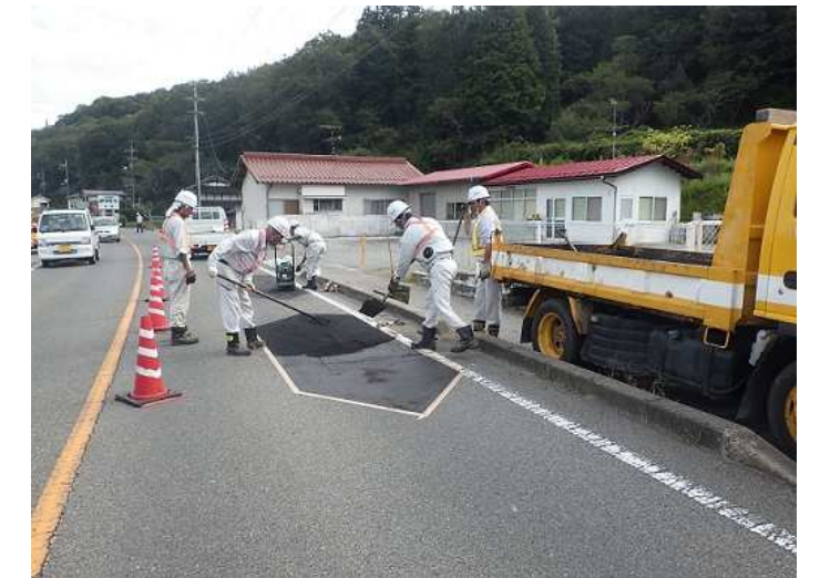
道路 ポットホール修繕状況
