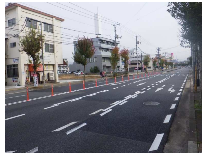
道路 舗装補修状況
