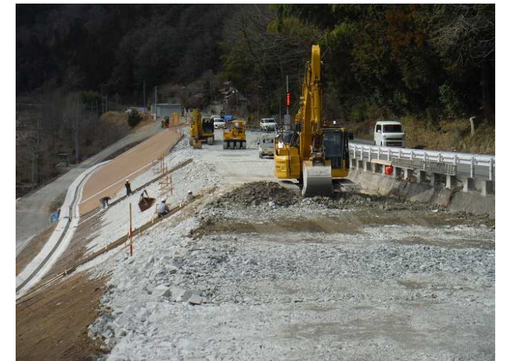
【道路改良】国道375号(日下～引宇根工区) 令和2年度工事
