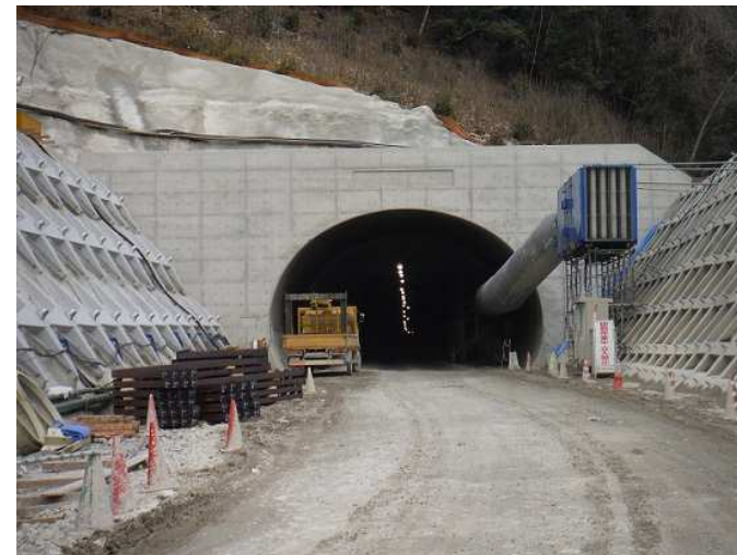
【道路改良】国道375号(日下～引宇根工区) 令和2年度工事 トンネル坑口部
