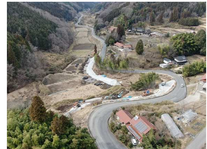
【道路再生改良】三次大和線（上田町） 令和2年度 道路拡幅工事
