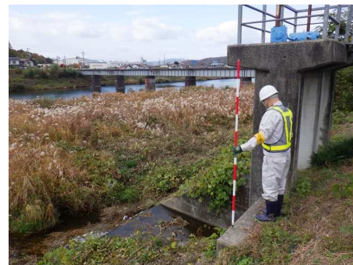
河川樋門 点検状況
