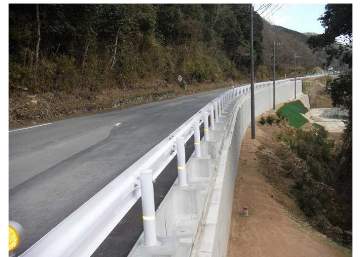
【道路改良】国道375号(日下～引宇根工区) 令和2年度工事 完成部
