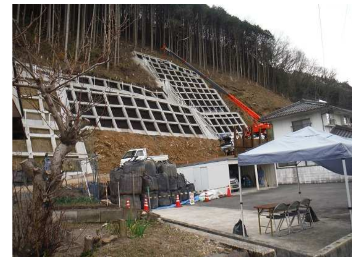
【急傾斜】南田地区（吉舎町） 令和2年度工事 法枠工
