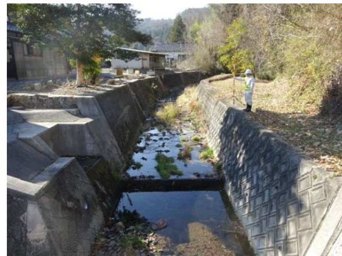
河川堤防 点検状況
