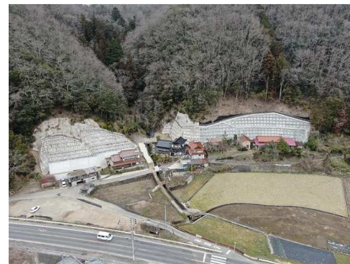
【急傾斜】山田地区（三次町） 令和2年度工事 待受擁壁工・法枠工
