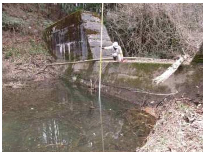
砂防堰堤 点検状況
