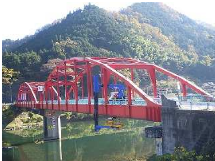
橋梁 点検状況
