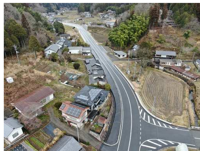
【交通安全】甲山甲奴上市線（甲奴町） 令和2年度工事 歩道整備
