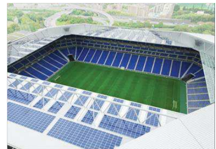
屋根に太陽光発電設備 (パナソニック(株)公式サイト)
