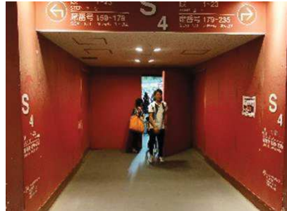
遮音性の高い扉 (ノエビアスタジアム神戸)
