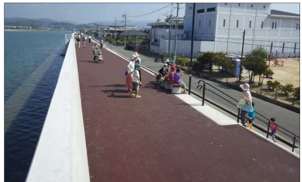
尾道糸崎港海岸堤防
