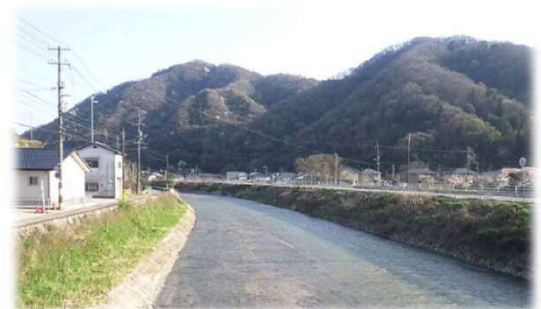
河川堆積土等の除去
