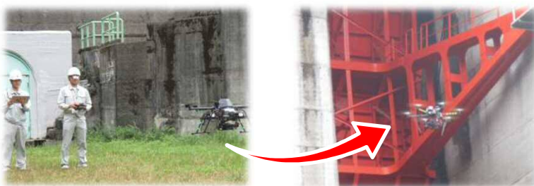
ドローンを活用した施設点検
