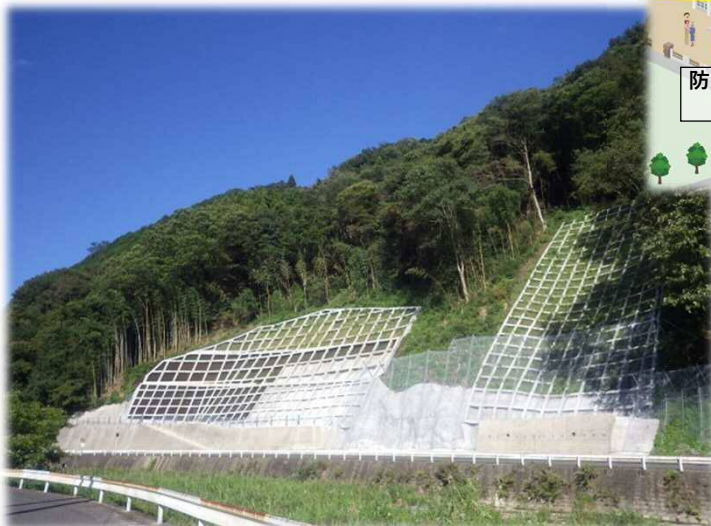
道路法面对策
