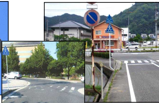
【老朽化した路側標識】
