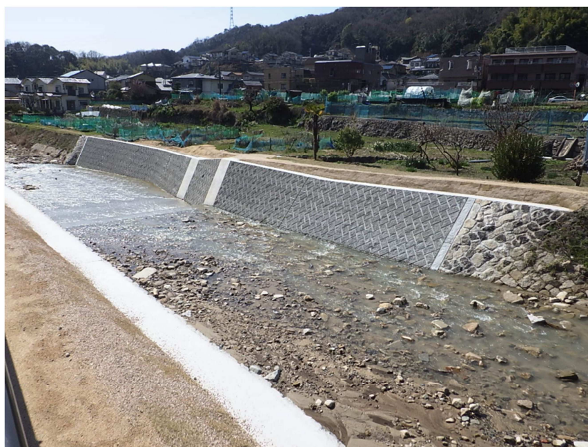
令和元年発生災害 一級河川太田川水系 府中大川 砂防設備災害復旧工事（広島市東区）
