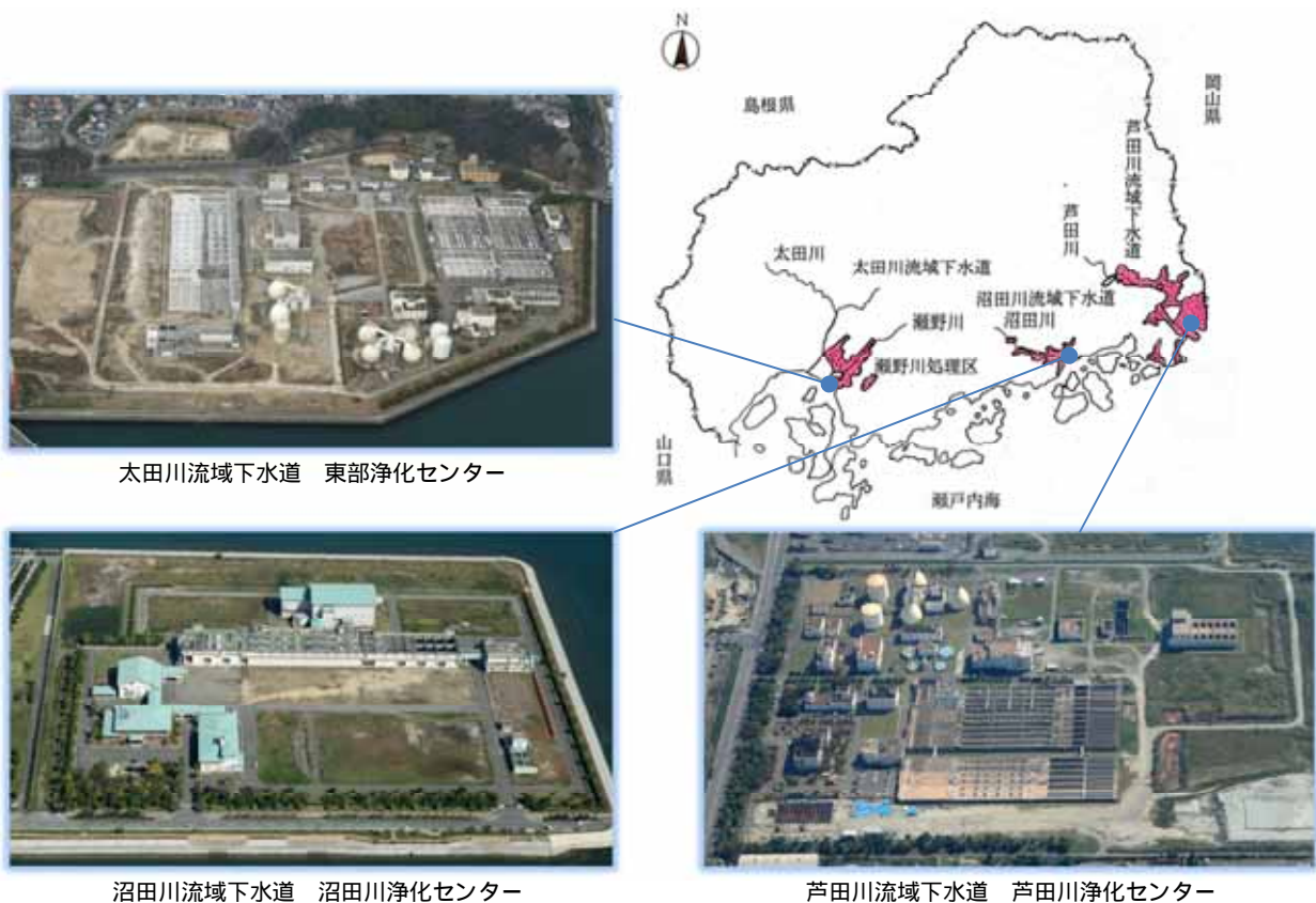
図 - 1 広島県流域下水道事業の区域及び処理場写真
