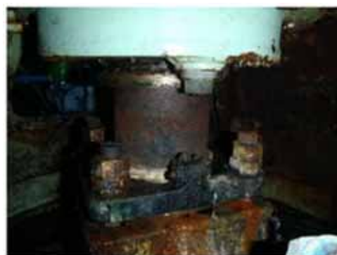
汚水ポンプ内部状況
