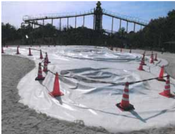
使用禁止措置(遠景)
