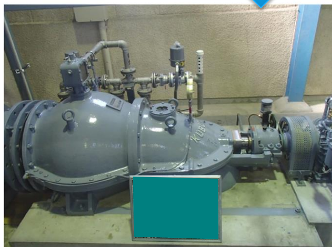
【排水ポンプ 修繕後】
