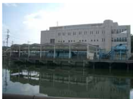
【手城川排水機場】
