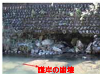
【堤防・護岸高齢化及び土砂の堆積状況】
