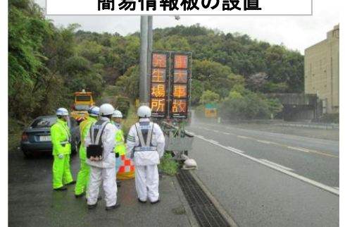
簡易情報板の設置
