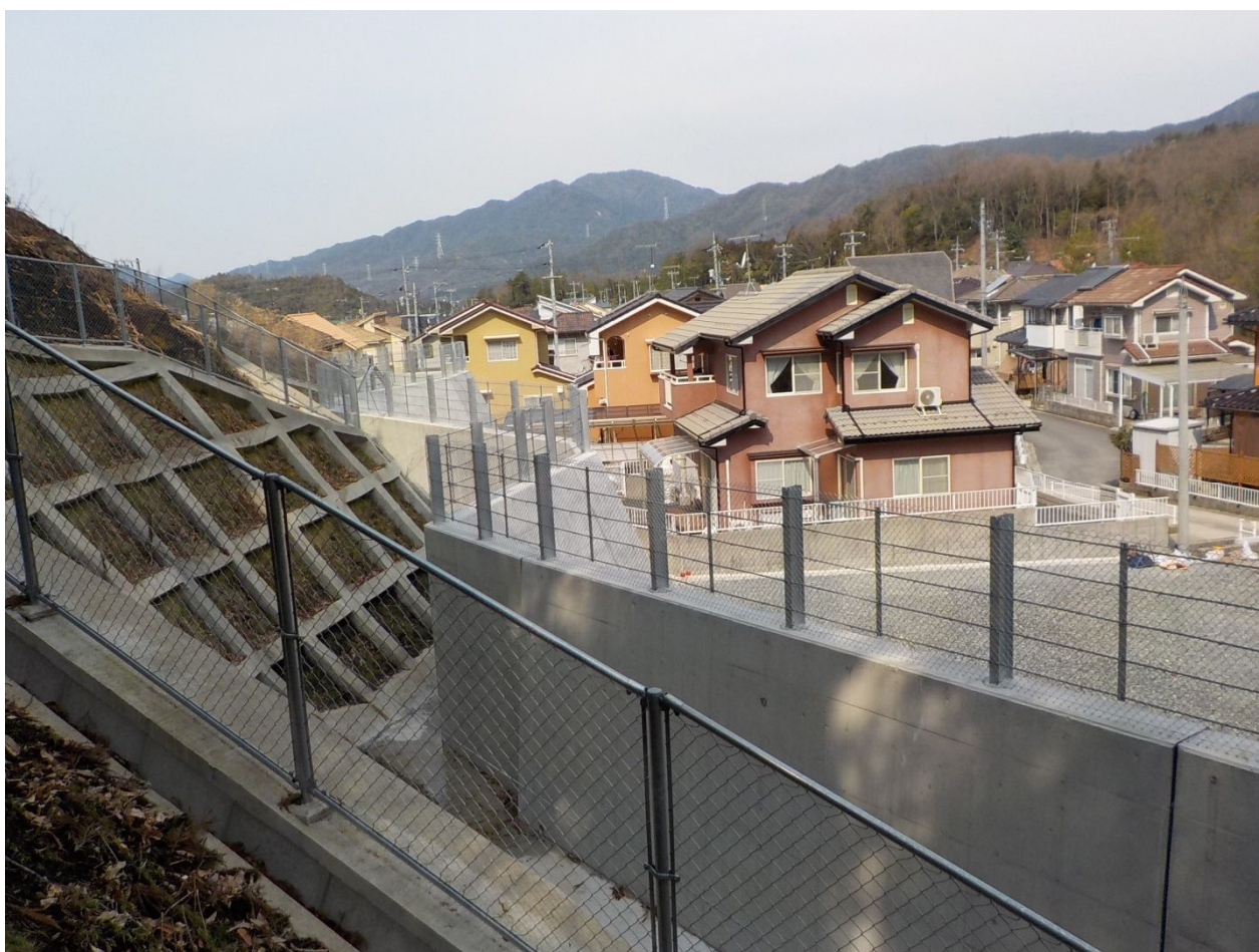
急傾斜地崩壊対策事業（広島市安佐北区）
