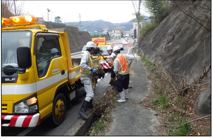
道路 側溝清掃状況
