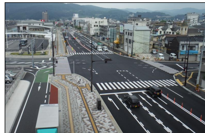
【改良】国道183号（十日市工区） 平成30年度工事 舗装工・用地取得
