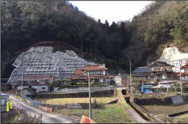
【急傾斜】山田西地区（三次町） 平成30年度工事 待受擁壁工・法枠工
