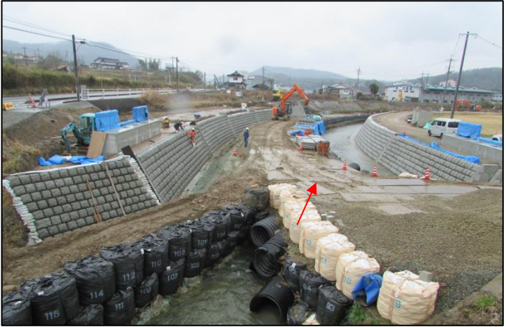
【改修】国兼川（和知町） 平成30年度工事 護岸工
