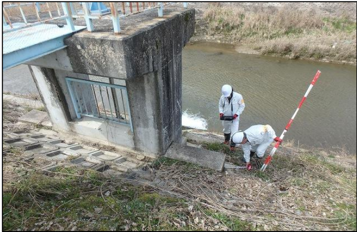
河川樋門 点検状況
