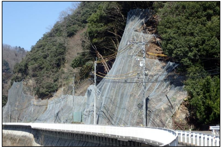
【落石対策】国道375号（作木町・芝坂工区） 平成30年度工事 落石防護網工
