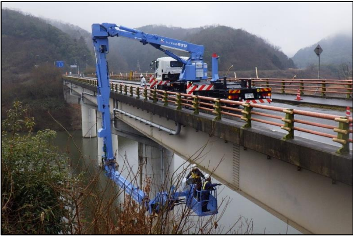
橋梁 点検状況
