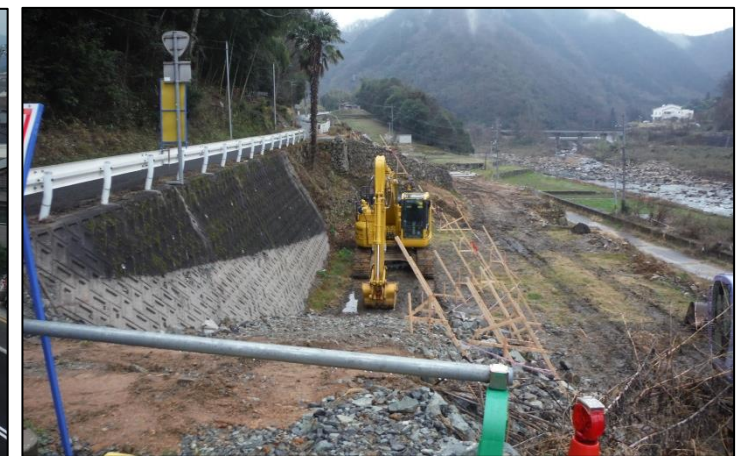
【改良】国道375号（日下～引宇根工区） 平成30年度工事 ブロック積工
