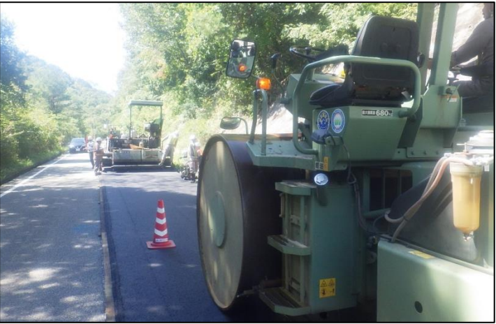
道路 舗装補修状況
