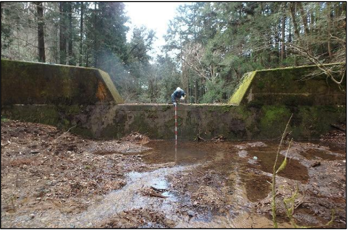
砂防堰堤 点検状況
