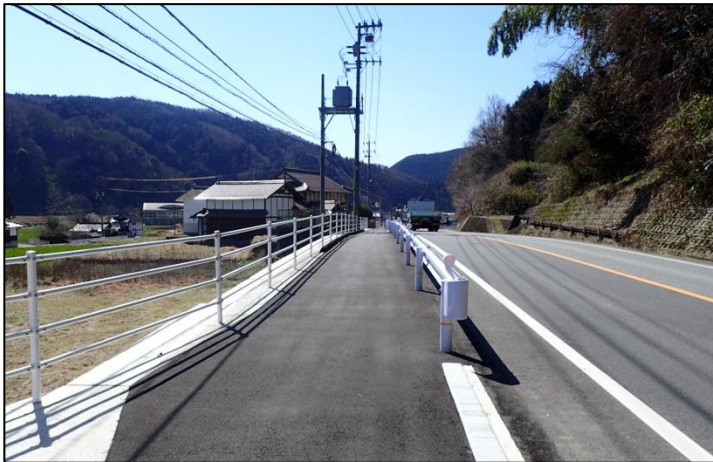
【歩道整備】三次高野線（西河内町） 平成30年度工事 舗装工・防護柵工 〔完成〕
