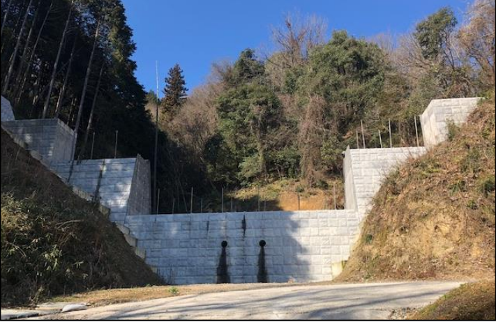
【砂防】中の村川4号（粟屋町・2基目） 平成30年度工事 堰堤工
