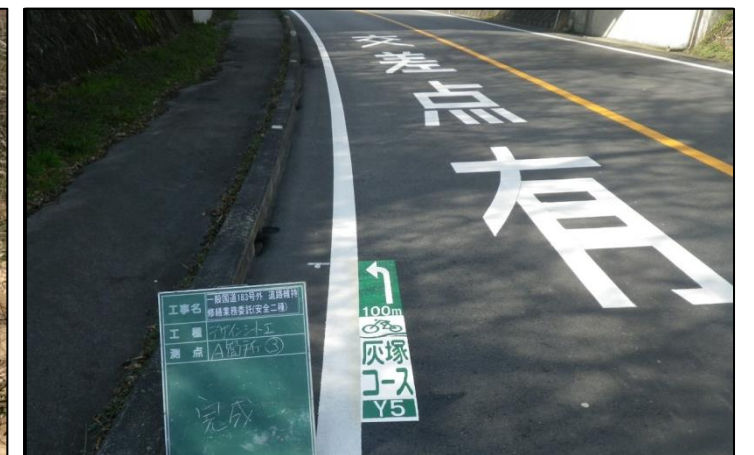
【観光資源】やまなみ街道サイクリングロード 平成30年度工事 ルート案内標示整備
