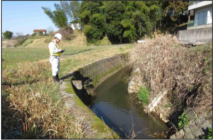
河川堤防 点検状況
