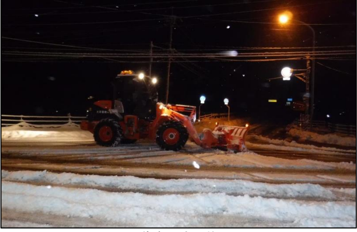
道路 除雪状況
