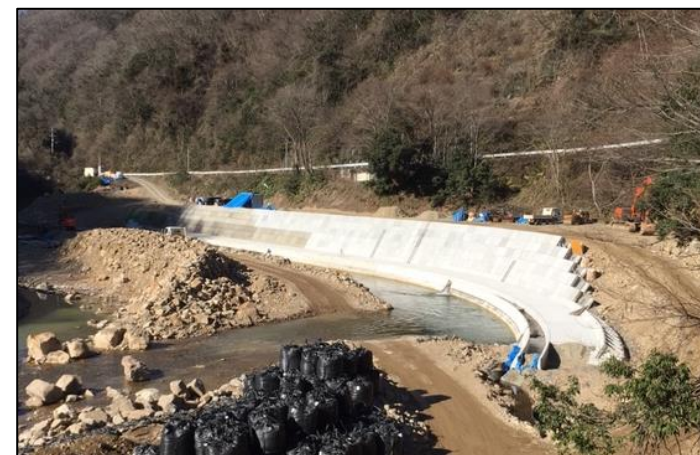
【改良】下門田泉吉田線（櫃田工区） 平成30年度工事 大型ブロック積工
