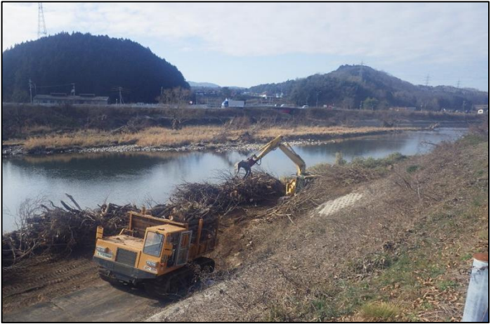
河川 樹木伐採状況
