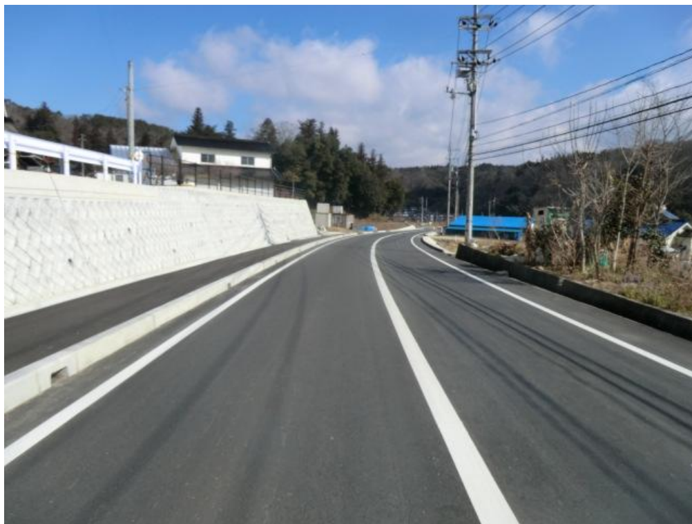
主要地方道 甲山甲奴上市線 三次市甲奴町小童
