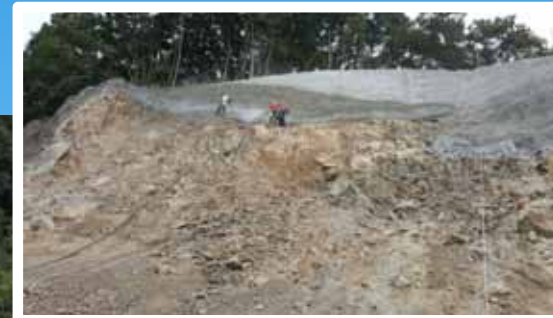
雨水浸透・浸食防止 仮設モルタル吹付 8月6日着手, 8日完了
