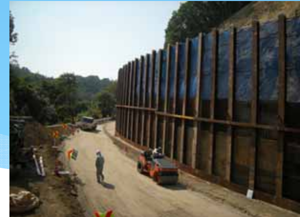
4日 仮設道路路盤工及び安全施設の設置着手。
