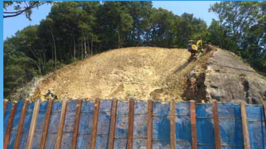
8月2日 斜面掘削機2台体制で、不安定土塊除去促進。
