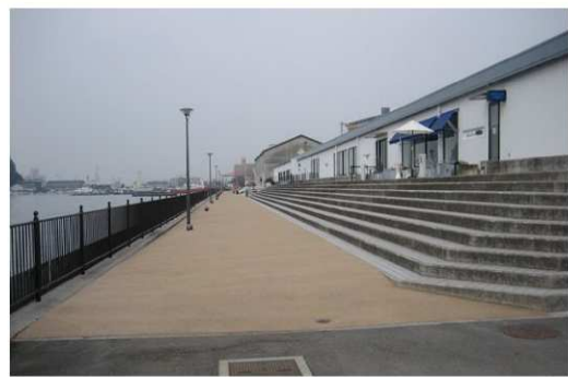
倉庫等を商業施設に利用転換し，賑わいの場としての利用促進(宇品デポルトピア)
