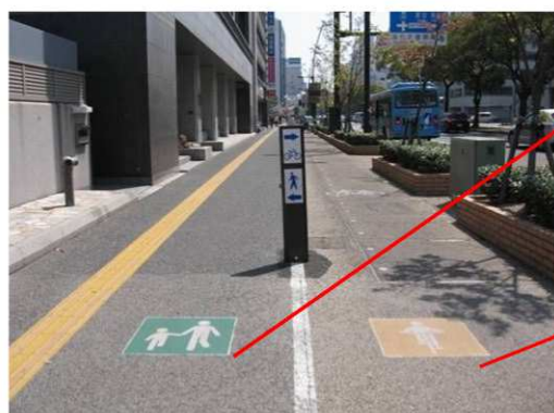
快適性・安全性の向上推進[歩行者・自転車道の分離](高松市)
