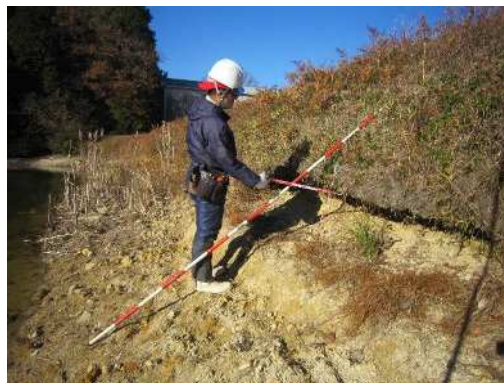
【図2 劣化・豪雨に対する診断の様子】
