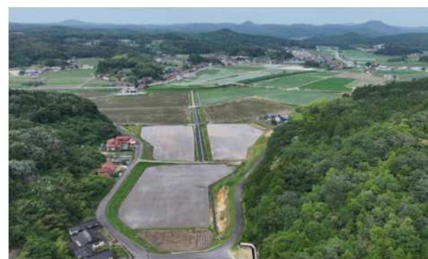
西大田地区 賀茂東工区(世羅町)
