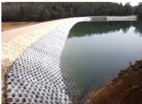
【図4 補強工事(改修)】
