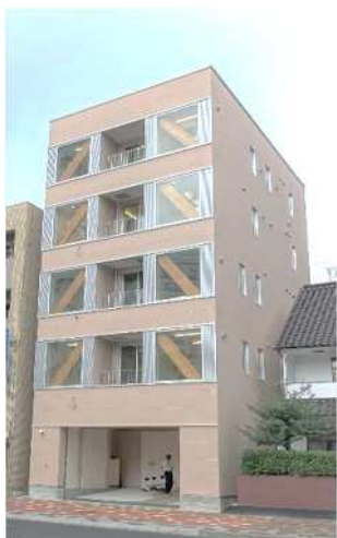
ひろしま木造建築協議会会員が設計した西日本初の純木造軸組工法5階建てビル（広島市）
