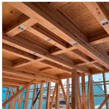
梁・桁、柱など木造住宅の主要構造部材として利用された県産材
