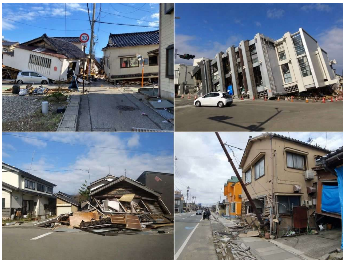
図表 1 - 1 令和6年能登半島地震における住宅・建築物の被害
