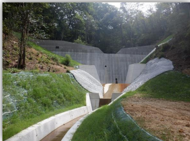
治山施設の整備
