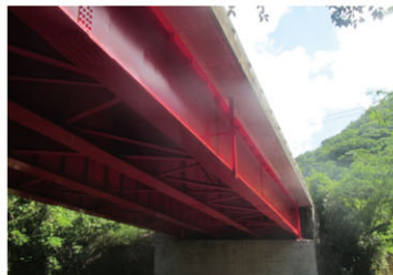
【橋梁補修】主要地方道 三次三和線 鬼ヶ城橋 (三次市)
