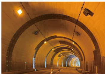
【トンネル補修】主要地方道 三原東城線 剣トンネル (神石郡神石高原町)
