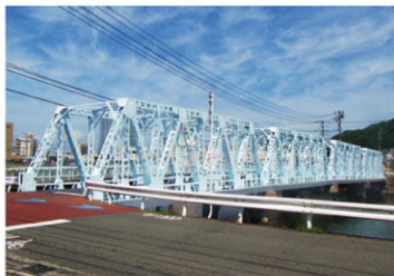
【橋梁補修】一般県道 海田府中線 九十九橋 安芸郡海田町
