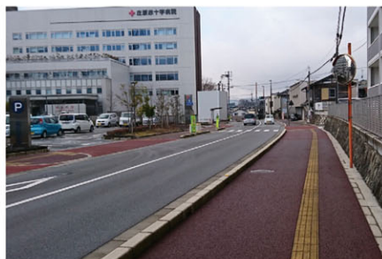
【現道拡幅】都市計画道路 高小路線 西本町工区 (庄原市)
