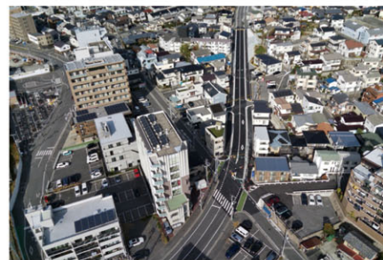
【バイパス整備】都市計画道路 青崎池尻線 青崎中～鹿籠工区 (芸芸郡府中町)
