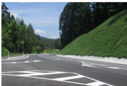
【バイパス整備】主要地方道 芸北大朝線 鳴滝工区 (山県郡北広島町)
