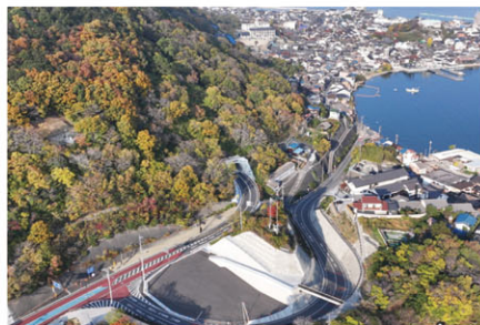
【バイパス整備】主要地方道 駒松永線 駒工区 (福山市)
