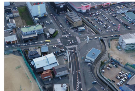
【現道拡幅】都市計画道路 上寺家下見線 西条東工区 (東広島市)
