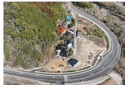
【バイパス整備】国道186号 御園バイパス (大竹市)
