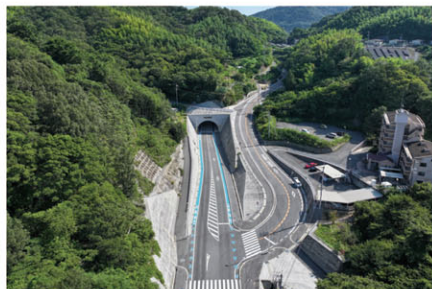
【バイパス整備】国道317号 青影バイパス (尾道市)
