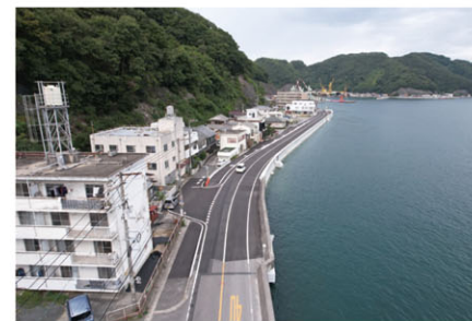
【現道拡幅】主要地方道 大崎上島循環線 天満工区 (豊田郡大崎上島町)
