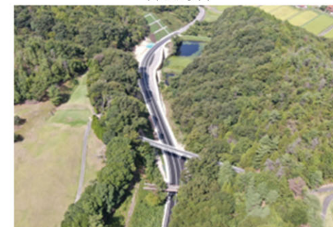
【現道拡幅】一般県道 三原本郷線 小坂町工区 (三原市)
