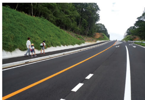
【歩道整備】一般県道 世羅甲田線 賀茂工区 (世羅町)
