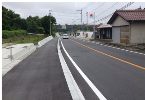
【歩道整備】国道 375号 敷名工区 (三次市)
