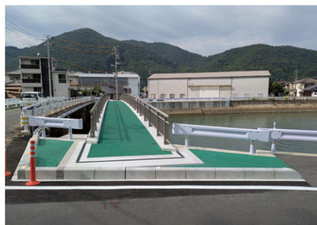
【歩道整備】一般県道 川尻安浦線 安浦中央工区 (呉市)
