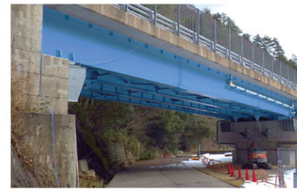
【橋梁耐震補強】国道186号 栗栖大橋（廿日市市）
