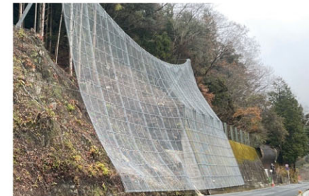
【法面对策】国道186号 下殿河内工区（山県郡安芸太田町）
